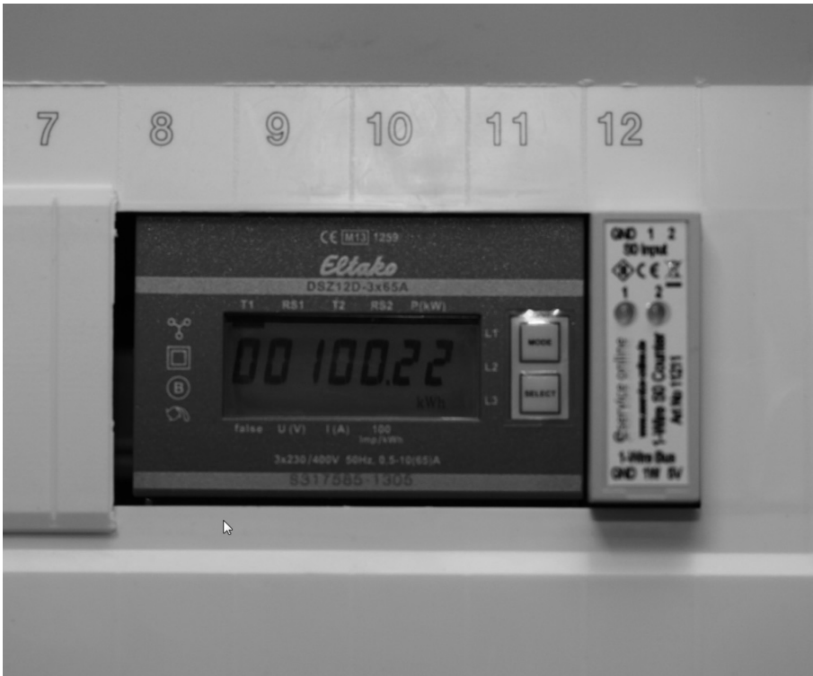
Bild 2.27: Der Anschluss des Eltako DSZ12D-3x65A ist vom Fachmann relativ schnell erledigt, vorausgesetzt, auf der Hutschiene ist noch genügend Platz.
