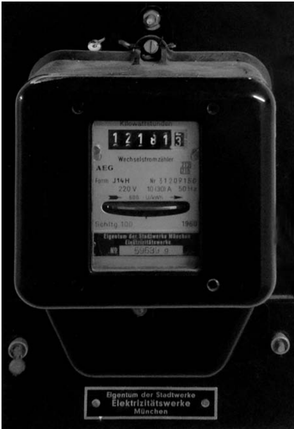
Bild 2.26: Drehstromzähler mit Drehscheibe: So oder ähnlich sind seit Jahrzehnten die Stromzähler der Energieversorger aufgebaut.
