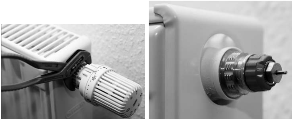
Bild 2.118: Der alte Drehthermostat wird gegen den Uhrzeigersinn vom Ventil heruntergeschraubt. Anschließend wird der Anschlussadapter für den Funkthermostaten aufgezogen.
