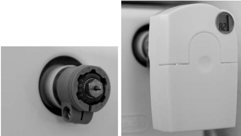
Bild 2.119: Erst wenn der Adapter korrekt montiert ist, lässt sich der neue Funkthermostat per Hand befestigen.
