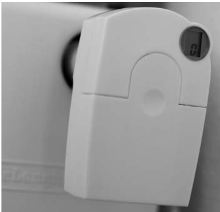
Bild 2.120: Erfolgreich am Heizkörper installiert: Im nächsten Schritt koppeln Sie den Funkthermostaten mit der Steuereinheit FHT 80B.
